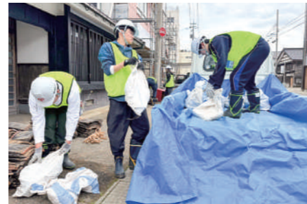
落ちた瓦の片付けをする様子(1回目)
